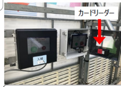
戸建住宅新築の狭い現場で、入場用・退場用に分けて、収納ボックスに格納してセット。
